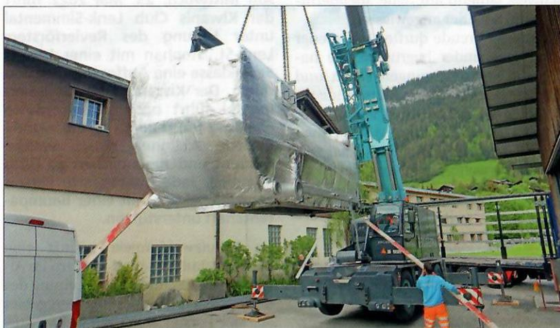
Der obere 23-Tonnen-Teil, in welchem dereinst das Heisswasser zirkuliert und der Elektrofilter die Rauchgase entfernt, beim Abladen aus dem Sattelschlepper.
