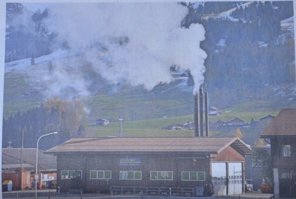
Noch ist die Fernwärmezentrale mit den Heizungskesseln unter der Werkhalle. Für das Erneuerungsprojekt wird die linke Hallenhälfte mit einem Anbau zur Verfügung stehen. Foto: Fritz Leuzinger
